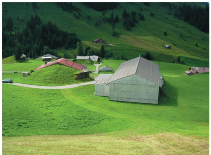
Die zur Lawine exponierten Wände können verstärkt werden, um das Gebäude zu stabilisieren (AWN, 2012). Abbildung: (AWN, 2012, p. 14).
